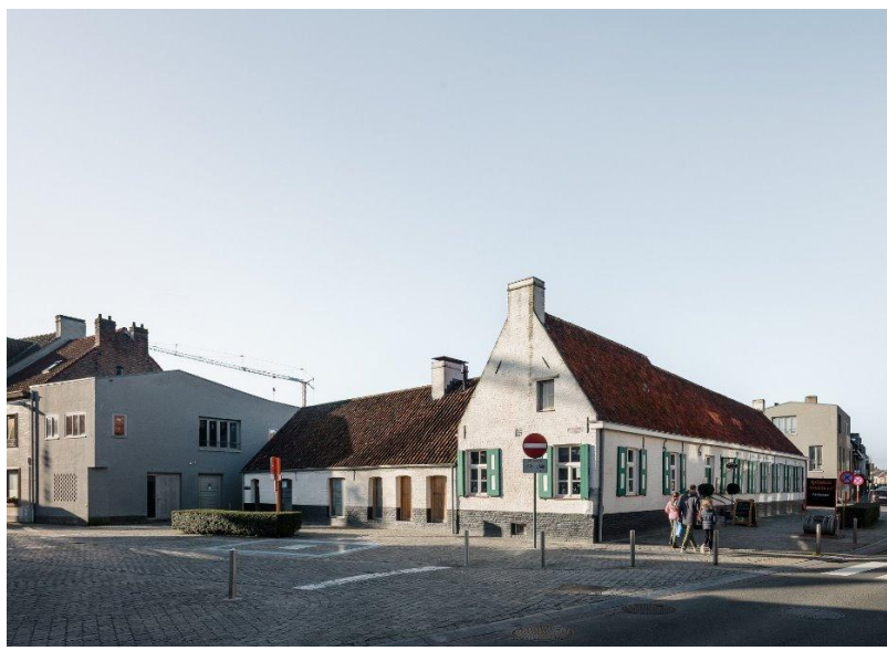
Woonerf Herberg Godelieve, Gistel (WWM architects) © Stijn Bollaert
