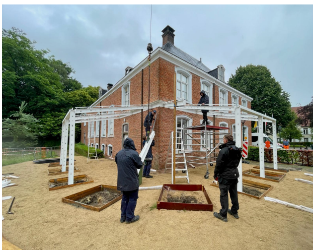
plaatsing stalen beschutting
