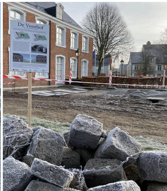
begin werkzaamheden: verwijderen kasseien
