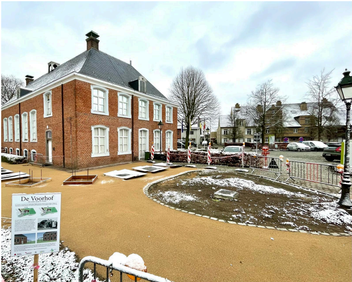
heraanleg ondergrond met infobord
